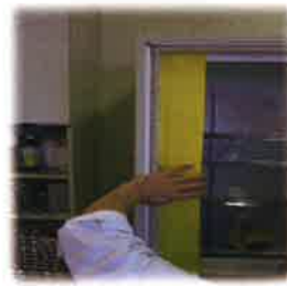
取り付け作業
